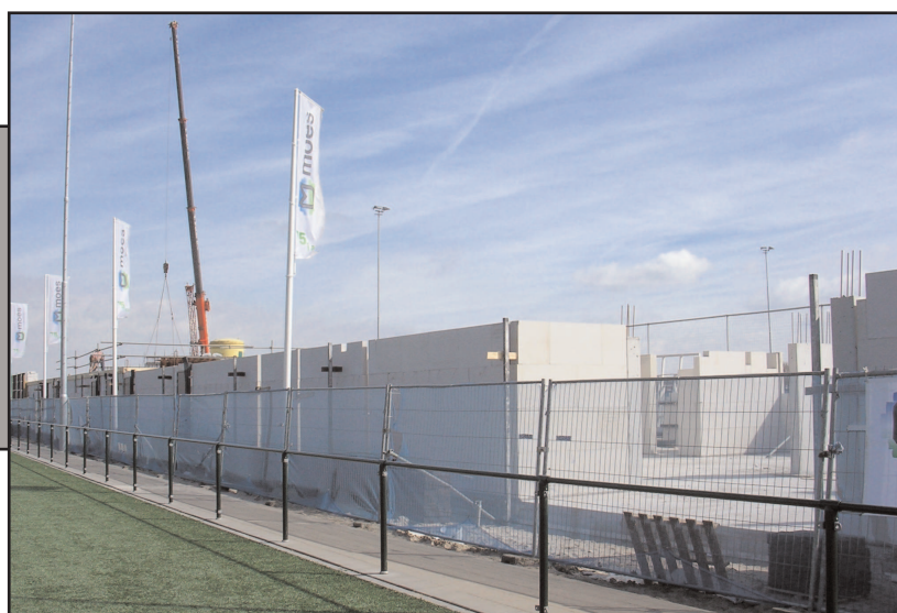
Het clubhuis in aanbouw
